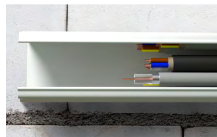
Incollaggio di canaline.
